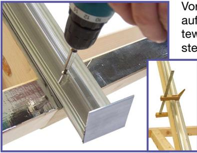
Vorbereitete Profilunterteile auflegen. Abschluss- und Haltewinkel können komplett überstehen (Wenn nicht möglich in den Sparren ausklinken). Profile exakt ausrichten, mit Zwingen fixieren und verschrauben.
