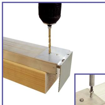
Legen Sie den Abschluss- und Haltewinkel an der Unterseite des Unterprofils so an der Kante an, dass der Wasserablauf frei bleibt (siehe Bild). Bohren Sie nun das Unterprofil 2 mal ( $\varnothing$  3,5 mm) vor.
