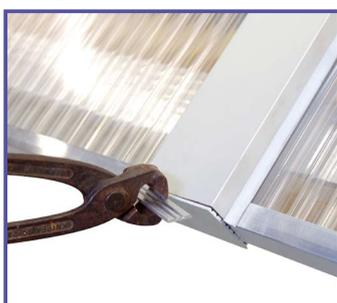
Nun kann der Abschluss- und Haltewinkel je nach Höhe des Profils (mit oder ohne Zierklemmdeckel) mit einer Zange abgebrochen werden.
