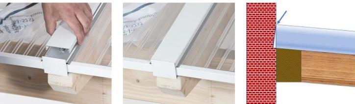
23. Das Wandanschlussprofil wird alle 50 cm vorgebohrt und mit geeignetem Befestigungsmaterial an der Hauswand befestigt. Die Gummilitze muss im Bereich der Profile eingeschnitten werden, damit sie Ihre Dichtwirkung erzielen kann. Im Anschluss wird die obere Kante mit Silikon versiegelt. Abschließend die Wandanschluss-Seitenteile anschrauben und mit Silikon abdichten.
