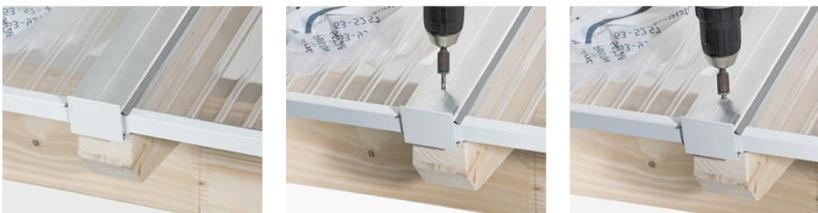
22. Die Klemmdeckel werden auf die Profile geklickt (bei Schwergängigkeit kann man mit einem Hammer nachhelfen, sollte dabei aber immer ein Schlagholz zwischenlegen). Die Randprofile erhalten auf die gleiche Art den Klemmdeckel mit Wetterschenkel, welcher aber am oberen Ende so angeschrägt werden muss, dass er an der Wand anliegt.
