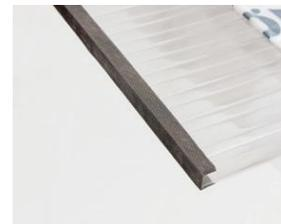
18. Über das Anti-Dust-Tape wird das Alu-Abschlussprofil mit den Ablaufbohrungen geschoben und auf der Oberseite mit Silikon abgedichtet. Weiße Abschlussprofile sind bauseits zu bohren.
