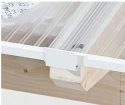
21. Die Deckel des Kompletprofil werden alle 25 cm in der mittleren Kennrinne vorgebohrt und auf die Unterprofile lose aufgelegt und mit den selbstschneidenden Schrauben 5,5 x 85 mm mit dem Unterprofil und der Unterkonstruktion verschraubt. Schrauben nur „handfest“ anziehen, bis ein leichtes Quetschen der Abdichtscheibe durch den Schraubkopf erfolgt, damit die Platten sich nachträglich noch ausdehnen können!
