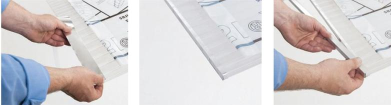
20. Die fertig vorbereiteten Platten werden nun auf die Unterprofile aufgelegt und winklig zur Unterkonstruktion ausgerichtet (zu beiden Seiten des Profils sollte Luft sein, um die Oberprofile aufsetzen zu können). In jedem Fall darf nur die UV-geschützte Seite der direkten Sonneneinstrahlung und Witterungseinflüssen ausgesetzt sein – also die Stegplatten immer mit der entsprechend beschrifteten Schutzfolie nach oben verlegen.
