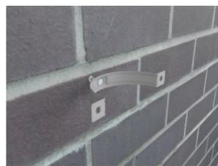
Die Montage der Schelle an der Wand erfolgt mithilfe eines Spreizankers.
