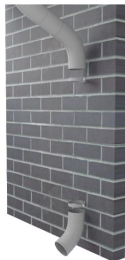
Anordnung der Fallrohrbefestigungsschellen
