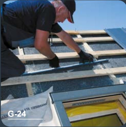
Mit einem scharfen Messer wird die Dachpappe angeschnitten. Es wird ein Spalt vorbereitet, in welchen die Dachmembran und die Rinne eingeführt werden.
