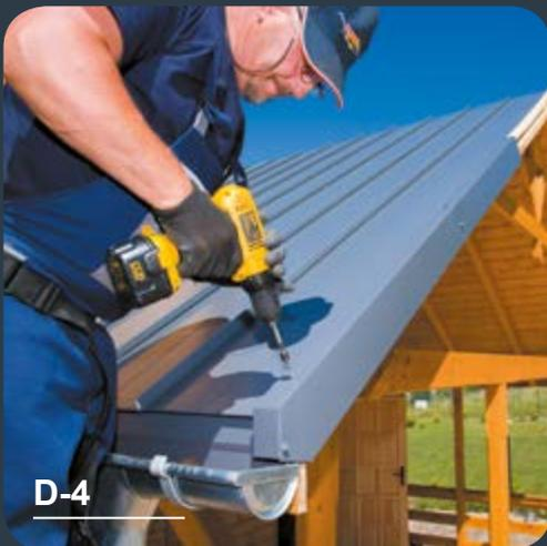
Der Ortgang wird mit Befestigungsmaterial (Empfohlen für den Außenbereich sind Edelstahlschrauben) mit Dichtung in der Farbe der Eindeckung befestigt.
