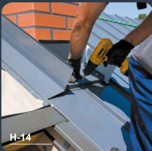
Das Kantelement wird nochmals angepasst und mit einer Schraube an der Rückseite des Falzes befestigt.
