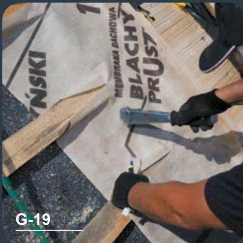
Die Membran wird ebenfalls direkt an der Dachfläche befestigt.
