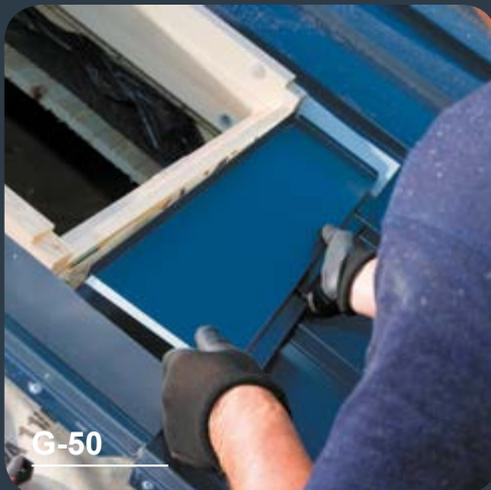
Die Kanteile sollten idealerweise dem Abstand der Seitenwände und der Fensterbreite entsprechen.
