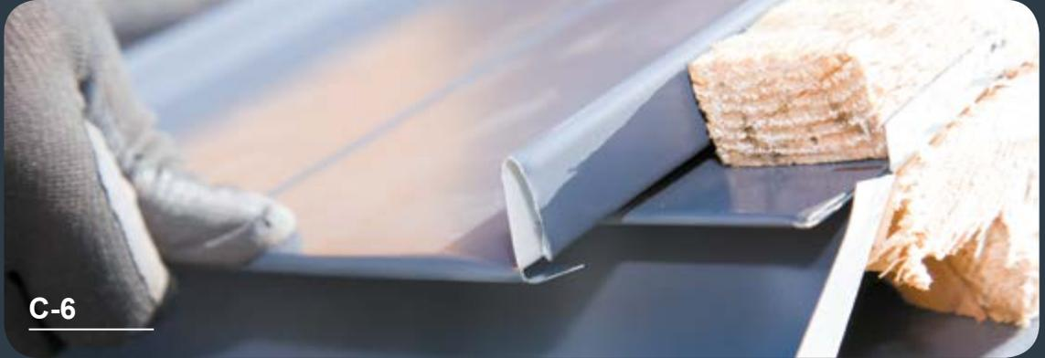
Die Erste Tafel wird parallel zur Giebelplatte verlegt.
