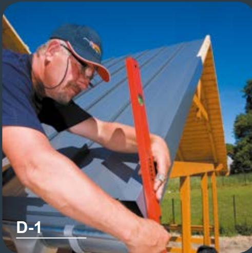
Die vorbereiteten Kanteile (Ortgänge) sollten unter Berücksichtigung des Neigungswinkels an den Dachrand angepasst werden.
