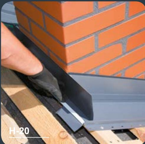
An der Spitze des Schornsteins machen wir eine abschließende Schürze, die in diesem Fall mit einem First eingedeckt wird.
