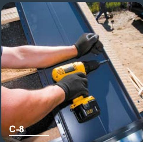
Die Platte wird mit Hilfe von Löchern in der Naht am Randstreifen befestigt - der Lochabstand beträgt ca. 700 mm (jede zweite Latte).
