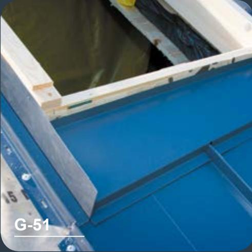
Bei der Verarbeitung schneiden wir den Platz für die Falz aus und passen die Elemente präzise an.
