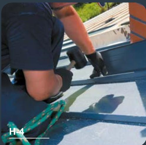
Nach der exakten Anpassung montieren wir die Schürze, indem das Schloss an dem daneben liegenden Panel eingerastet wird.
