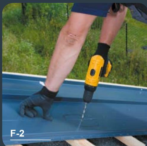
Legen Sie die Platte mit dem markierten Loch an die Dachfläche an – montieren Sie das Paneel vorerst nicht.
