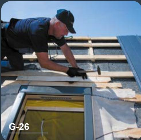
Zusätzliche Latten sollten an die Konterlatten genagelt werden, deren Länge größer sein sollte, als die Breite des eingebauten Fensters.
