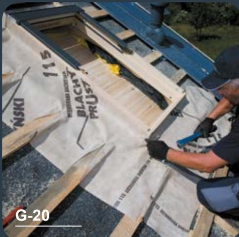
Die Ausführung der Eindeckung aus Unterspannbahn sollte sehr präzise gemacht werden.
