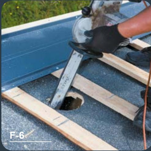
Gemäß Markierung wird das Loch in der Dachfläche ausgeschnitten. Es ist besonders darauf zu achten, dass mögliche (darunter verlaufende) Installationen an dieser Stelle nicht beschädigt werden.
