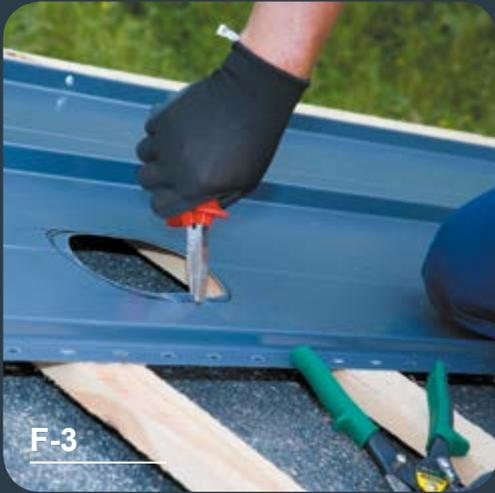
Mit einer Dachzange wird ein Kragen um das Loch geformt.
