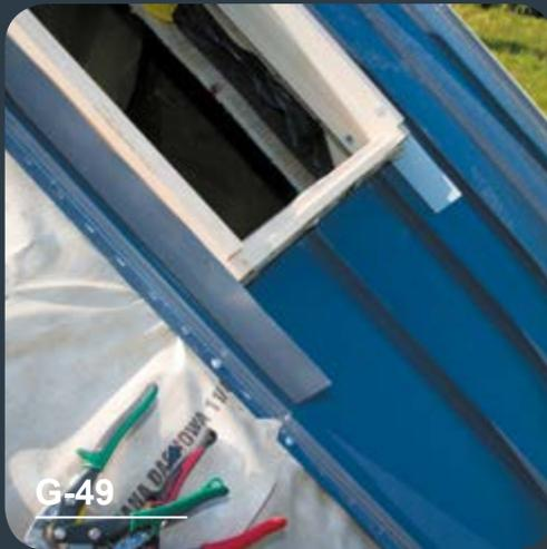
Der nächste Schritt ist die Durchführung der Verkleidungen unter dem Fenster.
