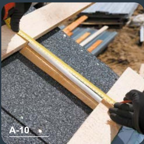
Zwecks der Einhaltung einer gleichmäßigen Entfernung zwischen den Latten, machen wir eine Messung. Eine solche Lösung beschleunigt die Arbeit maßgeblich. Es ist empfehlenswert, in diversen Abständen die Entfernungen zwischen den Latten zu kontrollieren.
