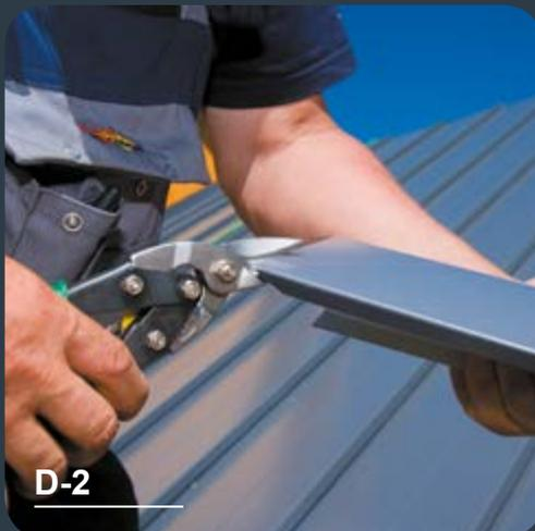
Nach der Markierung der Schnittlinie schneiden wir das überschüssige Material ab und lassen ca. 15 mm für die Umbördelung übrig.
