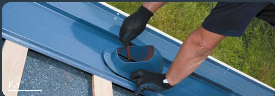
Der erste Schritt ist die Bestimmung des korrekten Lüftungsdurchgangs durch die Dachfläche. Am besten ist es, die Öffnungen in der Mitte der Dachpaneele zu planen. Es ist wichtig sicherzustellen, dass der Durchgang nicht in der Mitte der Latta markiert ist, die dann ausgeschnitten werden muss.
