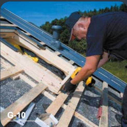
Das Fenster wird an den Latten vormontiert - oben und unten.
