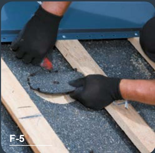
Auf der Dachfläche markieren wir ein Loch entsprechend der Form des Innendurchmessers des EPDM Abdichtungsflansches.
