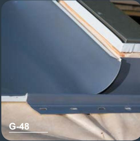
Die miteinander verbundenen Elemente (Oberschürze und Seitenschürzen) werden fixiert. Es ist auf ihre präzise Haftung an Fensterrahmen und Dachkonstruktion zu achten.
