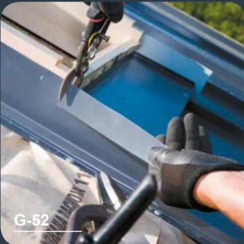
Die Seiten der Platten sollten so zugeschnitten sein, dass die Falzverbindung hergestellt werden kann.
