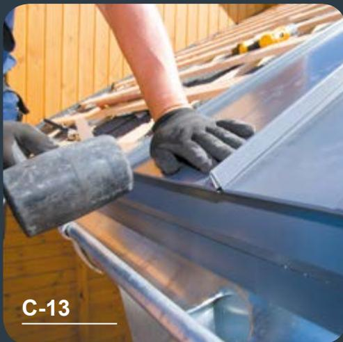
Wenn das Schloss über die gesamte Länge überlappt ist, schieben wir die Platte mit einem Gummihammer unter die Startleiste mit der Unterkante der Platte. Dann schrauben wird es auf den Latten befestigt.
