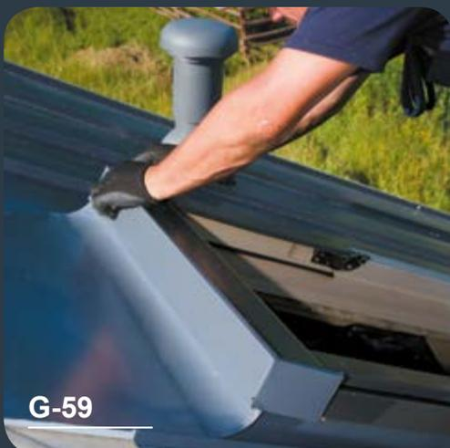
Mit Schrauben befestigen wir die Kanteile auf beiden Seiten des Fensterrahmens.
