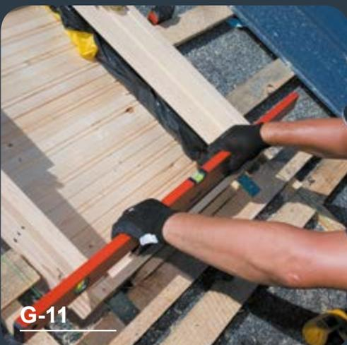
Nach der Erstmontage prüfen wir mit einer Wasserwaage, ob der Fensterrahmen gleichmäßig aufliegt.
