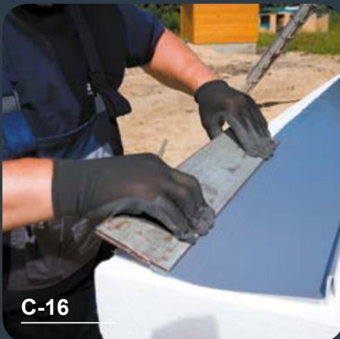
Nachdem Sie die Platte auf die entsprechende Breite zugeschnitten haben, biegen Sie die Seite in einem Winkel von 90 Grad.
