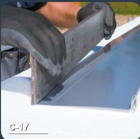
Die Biegung beginnt schrittweise und erreicht Schritt für Schritt einen Winkel von 90°.
