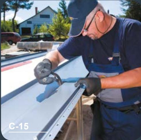
Je nach Abstand zur Wand oder zum Ende der Dachfläche müssen wir die Platte auf ihre Breite unter Berücksichtigung der vertikalen Faltung - ca. 25 mm (Befestigungsstelle an der Sockelleiste) zuschneiden.
