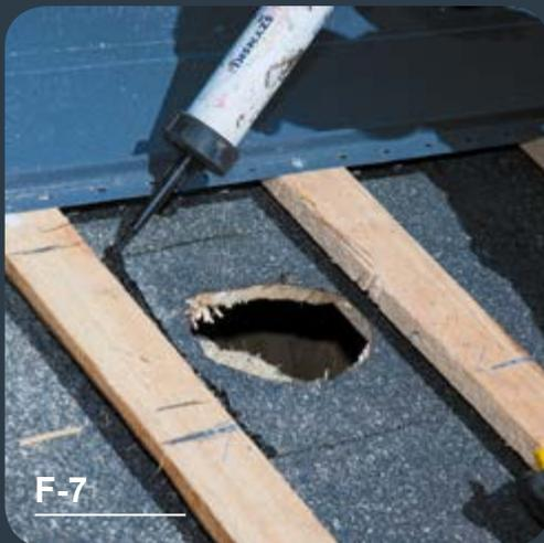
Die Kante der Abdichtung sollte mit einer Dichtungsmasse und bei Dachmembranen mit einem Spezialband, abgedichtet werden.
