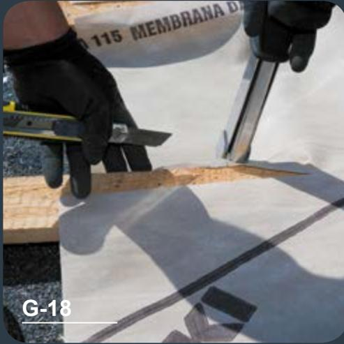
... und mit Hilfe von Klammern befestigen wir die Membran an der Seite der Latten.
