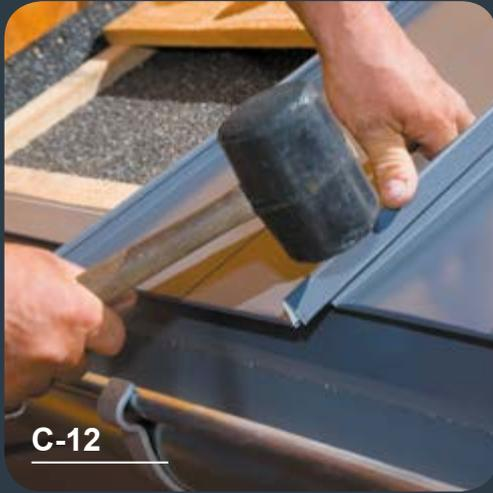
Für die Montage der Überlappungsstelle sollte ein Gummihammer verwendet werden.
