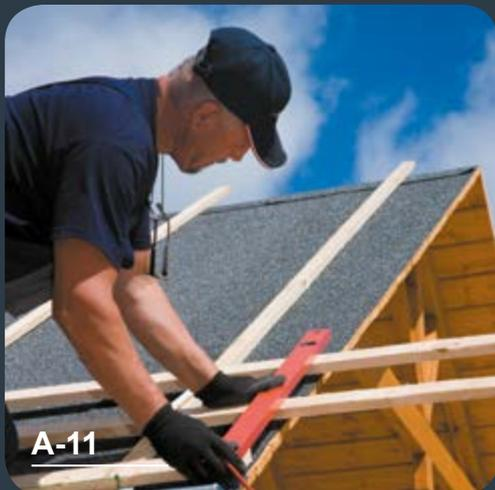
Die am Weitesten hinausragenden Latten sollten ausgeglichen werden. Dazu bestimmen wir eine Zuschnittslinie, welche exakt entlang des Seitenrandes der Dachfläche verlaufen sollte.
