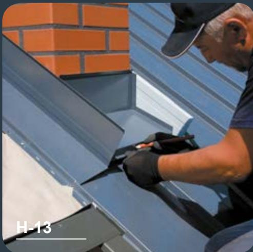
Markieren Sie die Stelle für das Stehfalz und die Schnittlinien an den Seitenschürzen.
