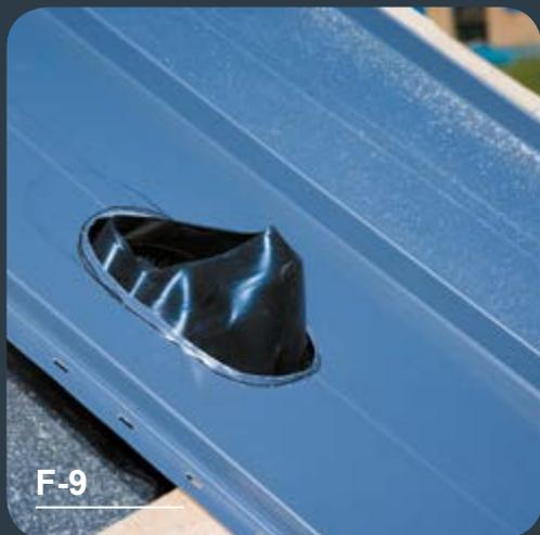
Nach der Befestigung der Abdichtung montieren wir die Platte mit der zuvor vorbereiteten Öffnung.
