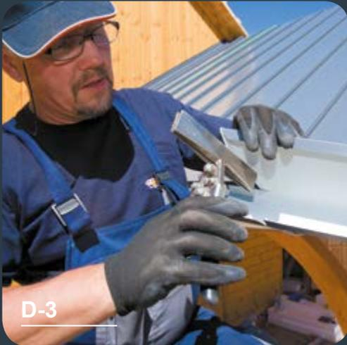
Mit Hilfe einer Dachzange bilden wir den Rand der Kanteile.
