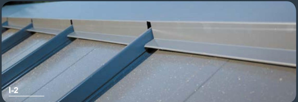
Im Kanteil werden die Stellen markiert, an der die Stehfalze platziert wird. Der Schnitt erfolgt mit einer Handschere.
