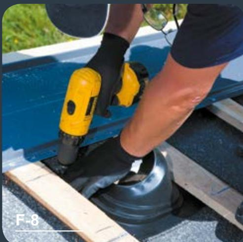
Mit Schrauben befestigen wir die Abdichtung direkt auf dem Dach.
