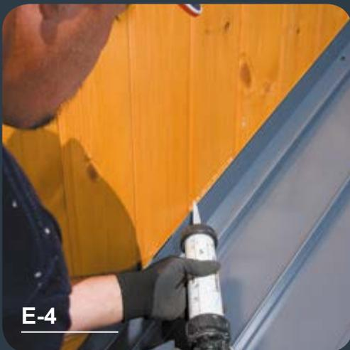
Der Wandanschluss hat oben eine gebogene Kante, die eine Versteifung und die Stelle für das Dichtmaterial ist.
