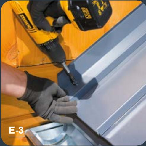
Mit Hilfe von Schrauben für Holz befestigen wir die Kanteile an der Holzlatte entlang der Dachfläche.
