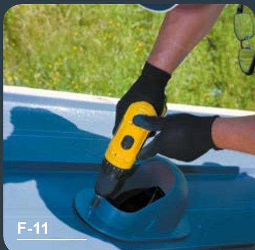
Nach sorgfältiger Einstellung befestigen wir das Entlüftungselement mit Schrauben am Paneel.
